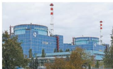
Рис. 42.9. Хмельницька АЕС: 2 атомні енергоблоки потужністю 1000 МВт кожен
